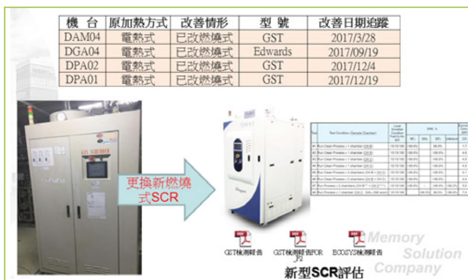
▲ 圖 4.10 舊型電熱式尾氣處理設施汰換成評估及執行成果
